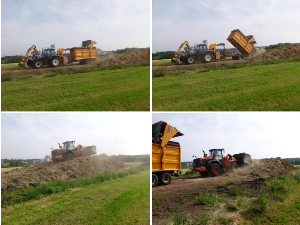
Figuur 3. Aanleg van de bermgraskuil
